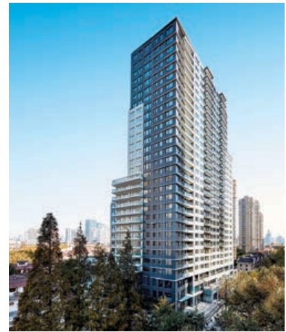
上海嘉御庭三期 — 傲峰 The Palace III – Le Haut, Shanghai
